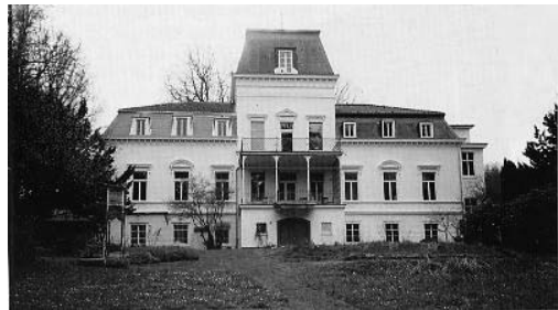
Herrenhaus von Gut Melb, 1881 umgebaut, aus Berzheim 2001, S. 51
