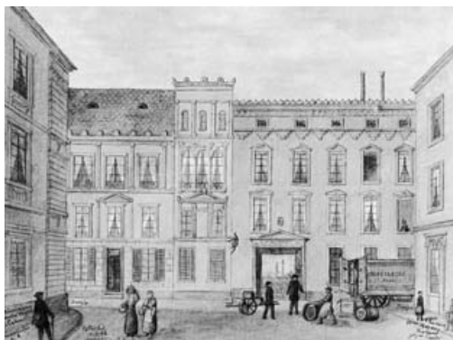
Häuser am Vierecksplatz, rechts mit Durchfahrt Nr. 825, 1897/98, nach Schlossmacher 2007, S. 68
