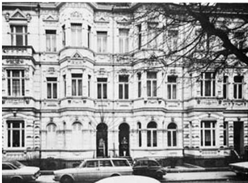
Lessingstraße 36-42, Zustand 1970, aus Landeskonservator 1973, Nr. 41
